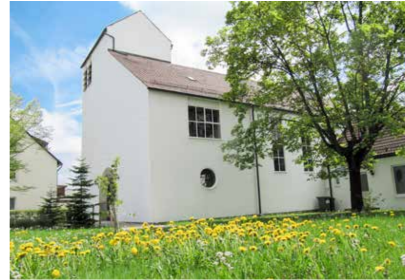
1 Außenansicht der ev. Auferstehungskirche
