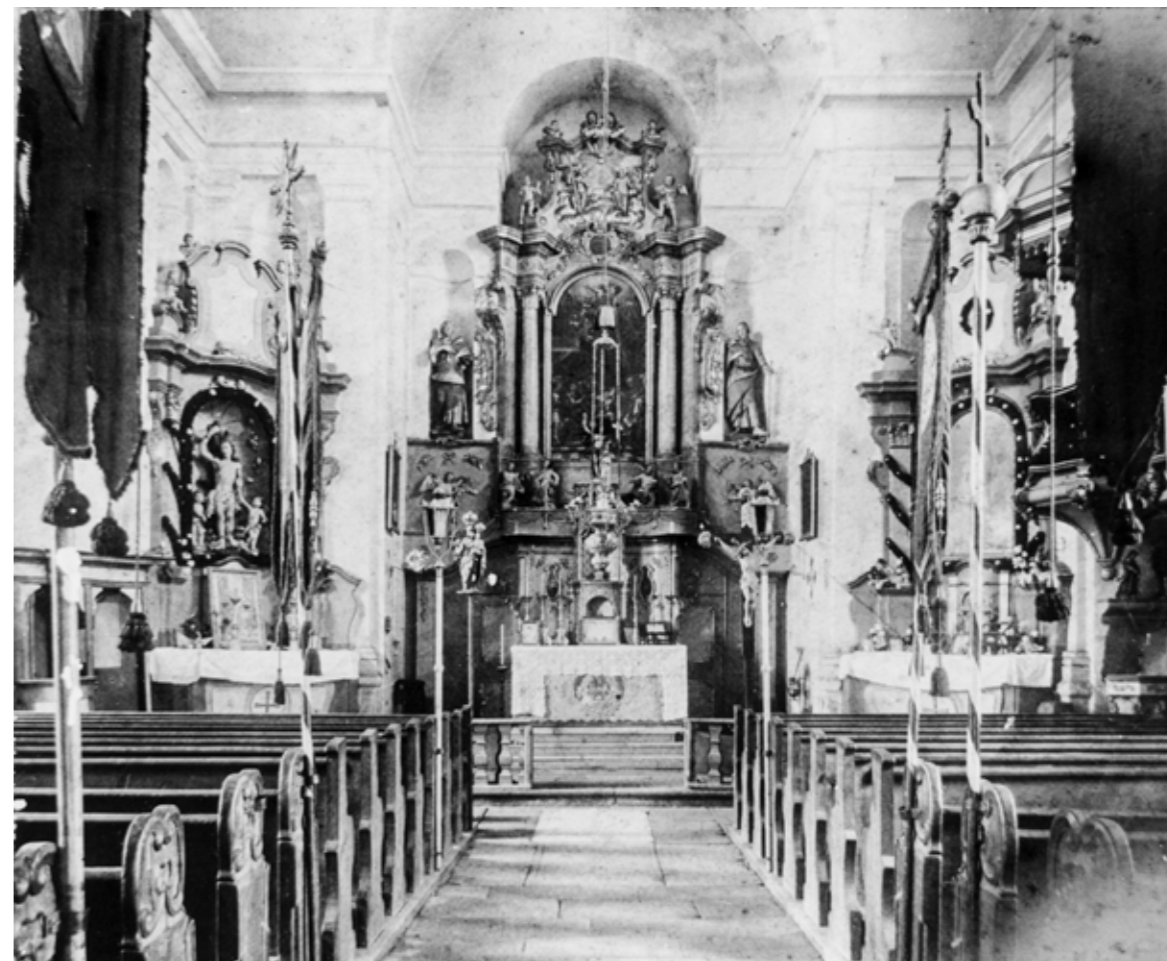
5 Innenansicht gegen Osten (Altarraum)
