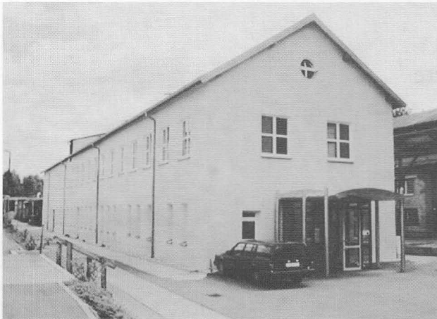
Mittelstandszentrum Maxhütte nach der Sanierung
