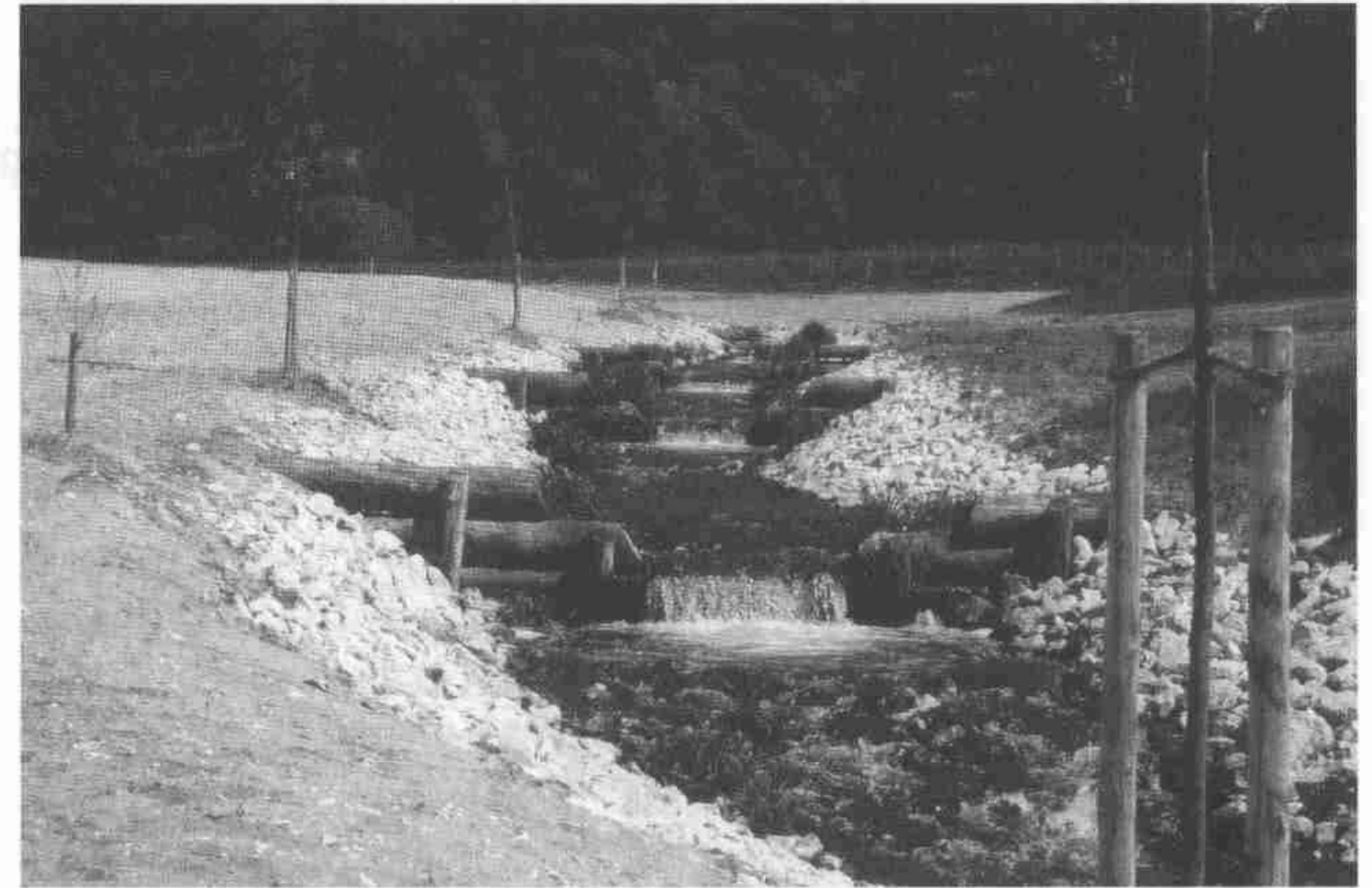
Sulzeinleitung bei Fertigstellung
