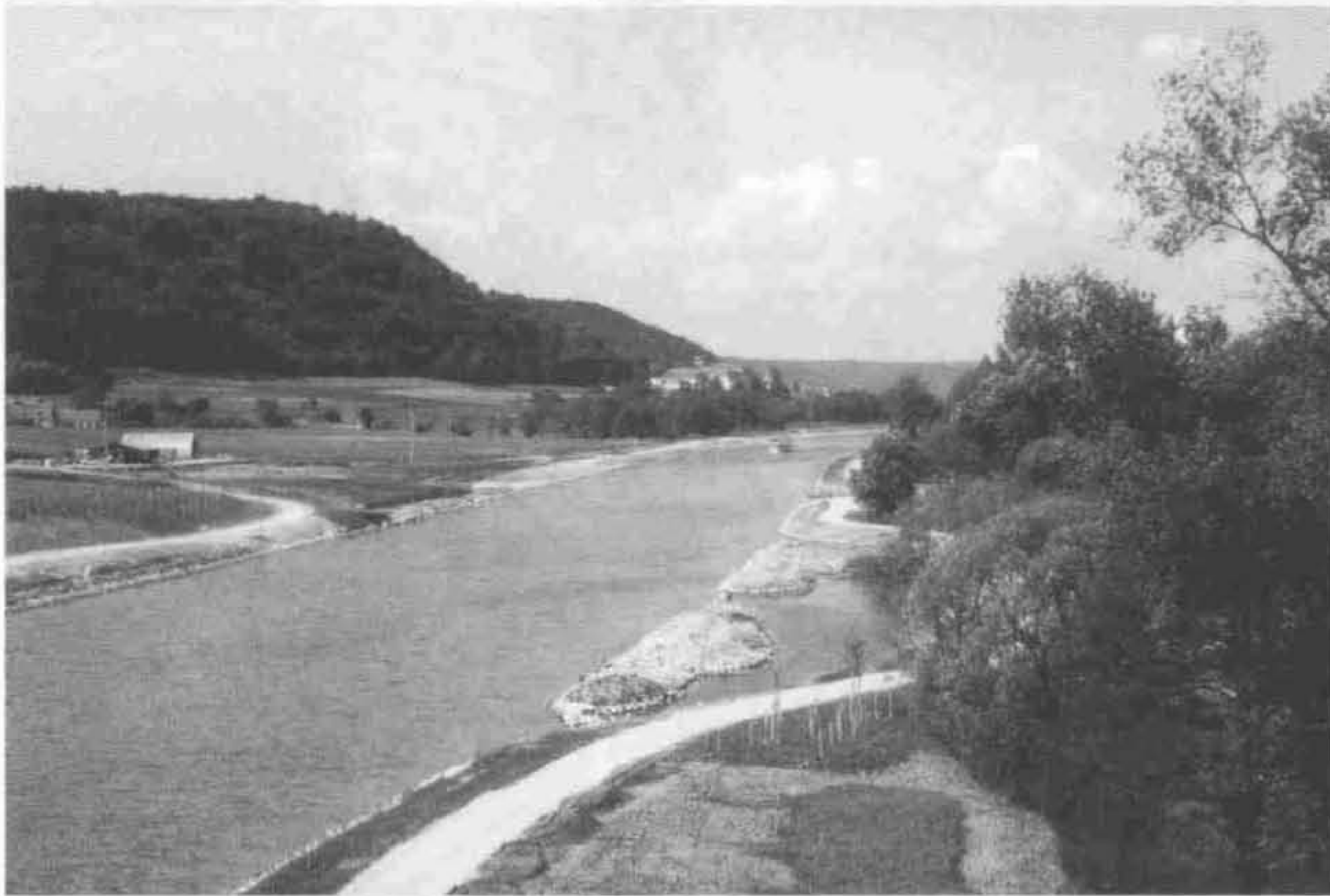
Kanalaufweitung bei der Fertigstellung 1993
