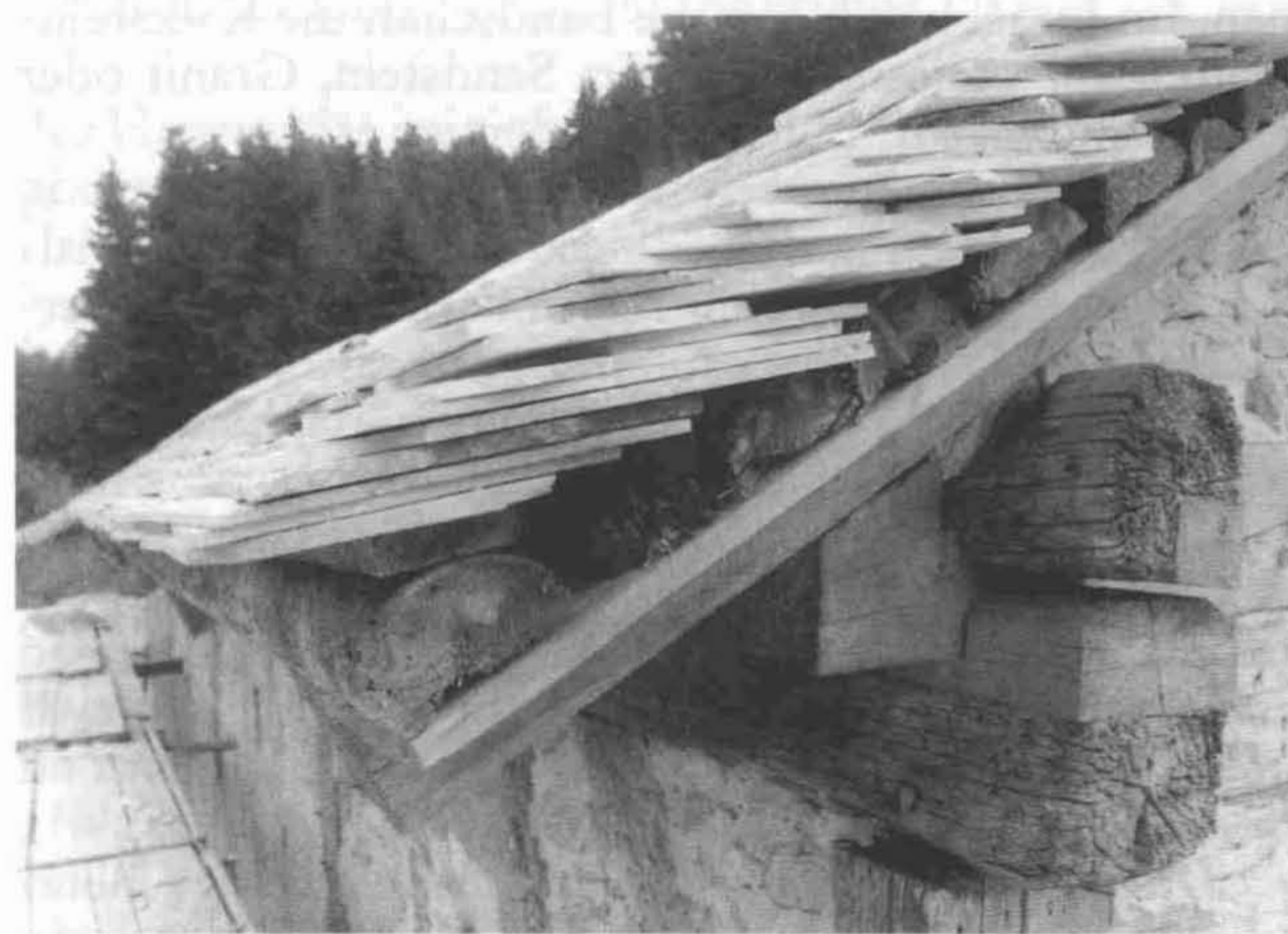
Frischgedecktes Kalkplattendach
