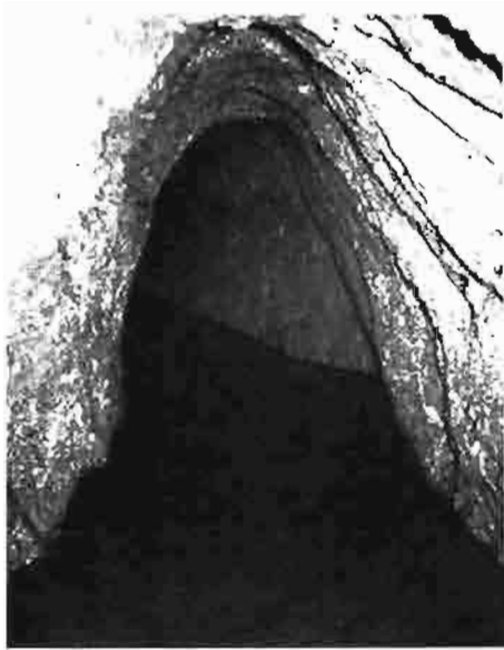
Blick in den Stollen „Kaaghof“ bei Nittenau (Foto G. Eigler (1970))
