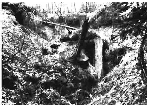
Verbrochenes Stollenmundloch der Grube Kaghof bei Nittenau (Foto G. Eigler (1970))
