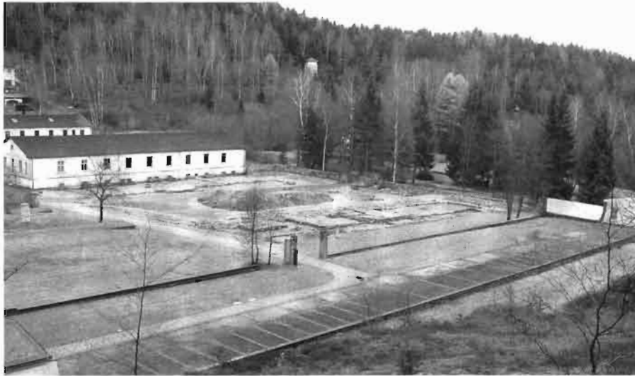
Blick auf den ehemaligen Arrestbau des KZ Flossenbürg, die Barackenfundamente des Häftlingsreviers und die Lagerwäscherei im Hintergrund, 2002
