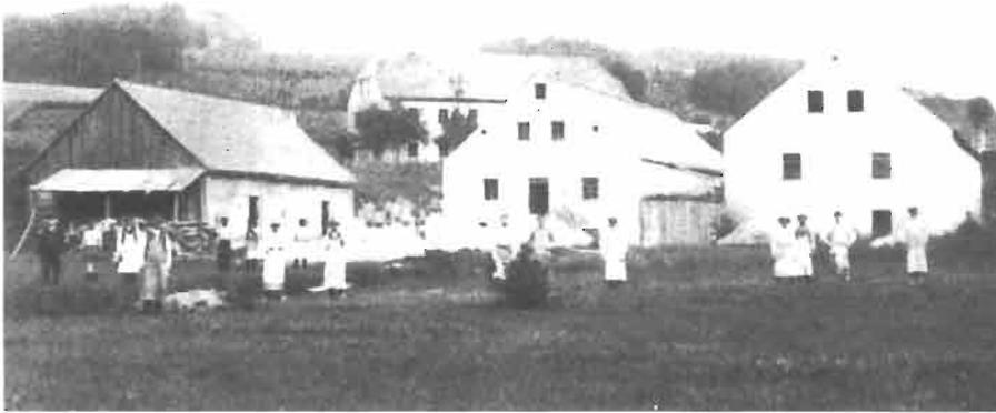
2 Typische Anordnung der langgestreckten Gebäude eines Schleif- und Polierwerkes zu beiden Seiten des Werkgrabens. Im Vordergrund die Belegschaft. Oberer Peugenhhammer, 1887
