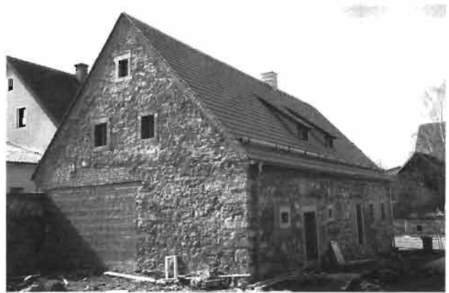
Sanierung eines Bauernhauses aus dem 18. Jahrhundert in Altenstadt bei Vohenstrauß
